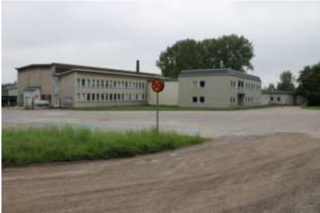
Tidigare laboratoriet vid Hynneberg 411-413 – Hynneberg 1:21
