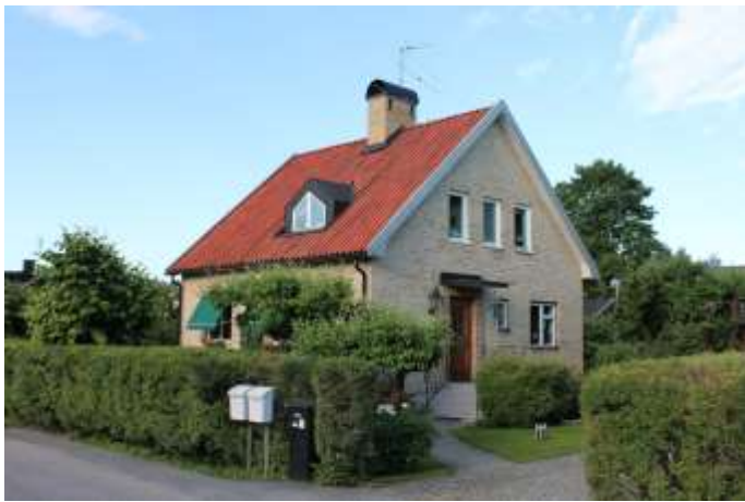
Bostadshuset på Kvarngatan 44 i Kumla har en välbevarad 1950-talskaraktär men uppfördes egentligen i början av 1900-talet. Bilden är tagen från nordost.
