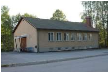
Länkarnas hus vid S:t Torgils väg 3 – Ingenjören 2
