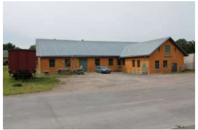
Stenarbetsmuséet mellan Yxhultsvägen 11 och 13– Hällabrottet 1:14
