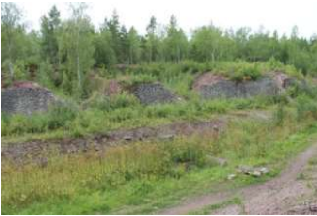
Rester av kalkugnar – Hällabrottet 1:14
