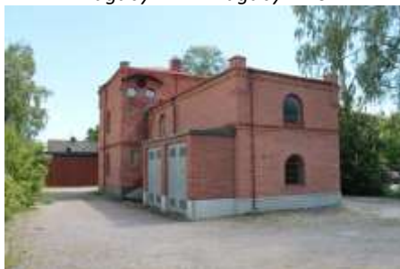
Transformatorstation vid Södergatan 17 – Tärnan 15
