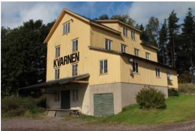
Den elektriska kvarnen i Hardemo med sina tätt spröjsade fönster och skärmtak vid lastbryggan i nivå med vägen är ett tydligt exempel på en enklare industribyggnad utom tätorten Kumla.
