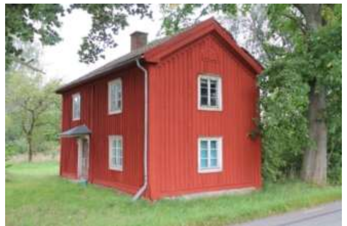
Vid Västra Åby Mellangården 104 – Västra Åby 2:2
