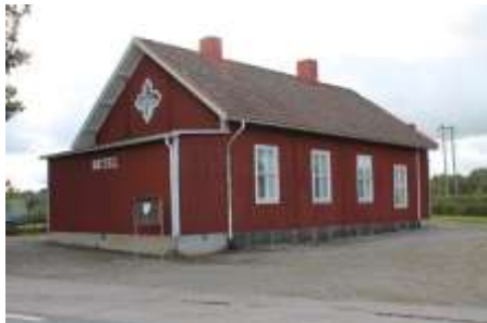
Tidigare Betelkyrkan vid Julsta 125 – Julsta 3:7
