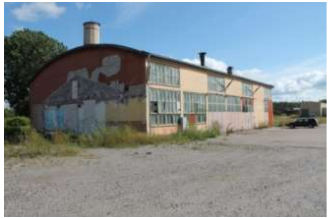
Tidigare verkstad vid Mexivägen 5 – Kvarnorp 6:8
